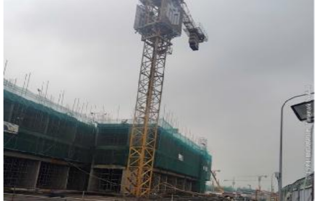
CÔNG TRƯỜNG THI CÔNG
